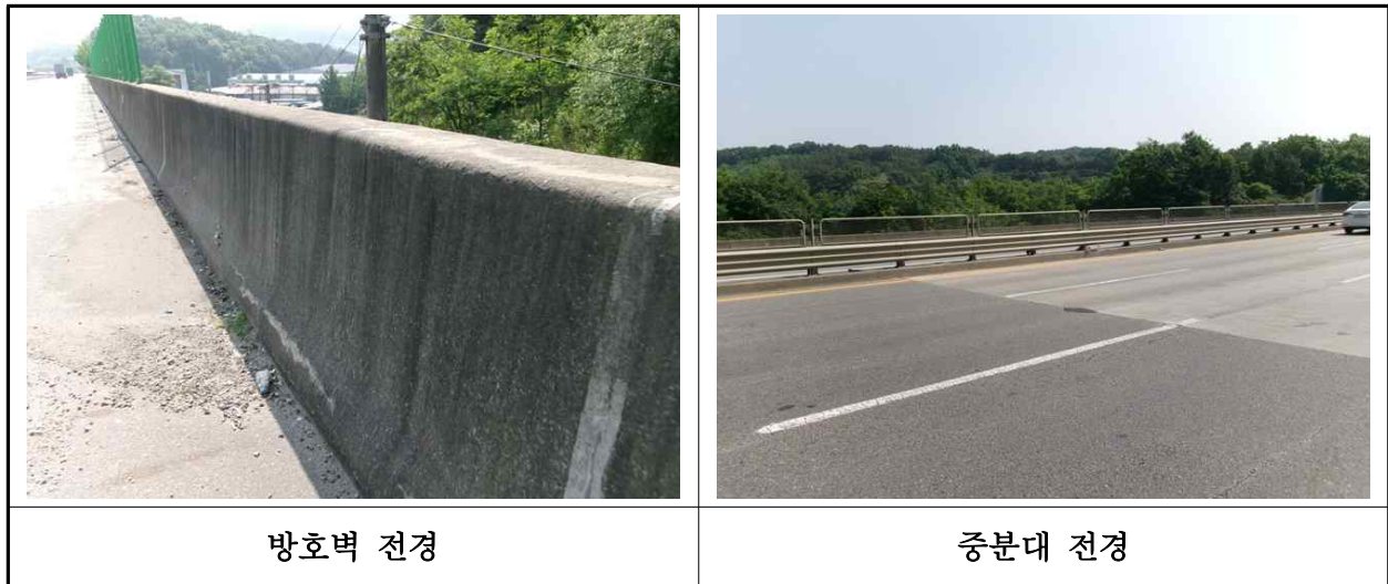
【사진 1.3.25】 방호벽 및 중앙분리대 전경
