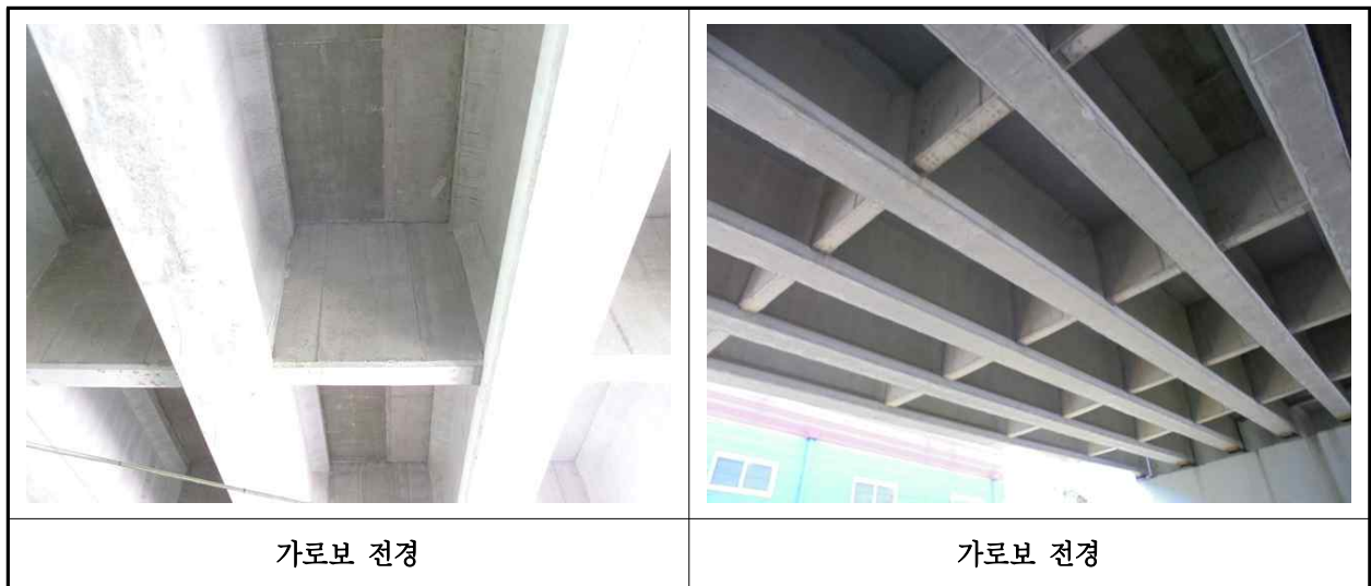
【사진 1.3.6】 가로보 전경
