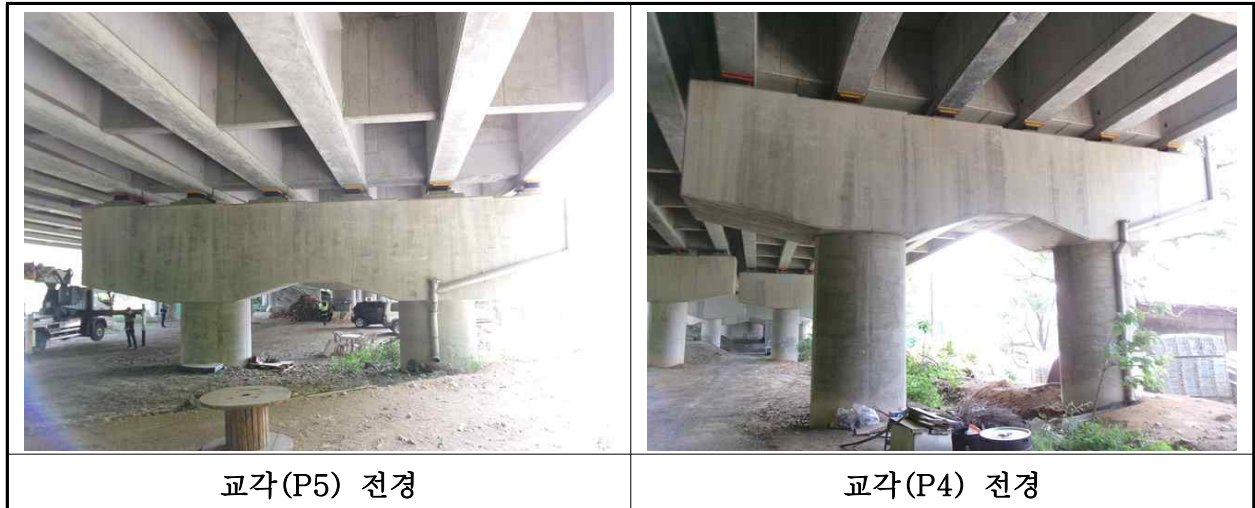
【사진 1.3.10】 교각 전경
