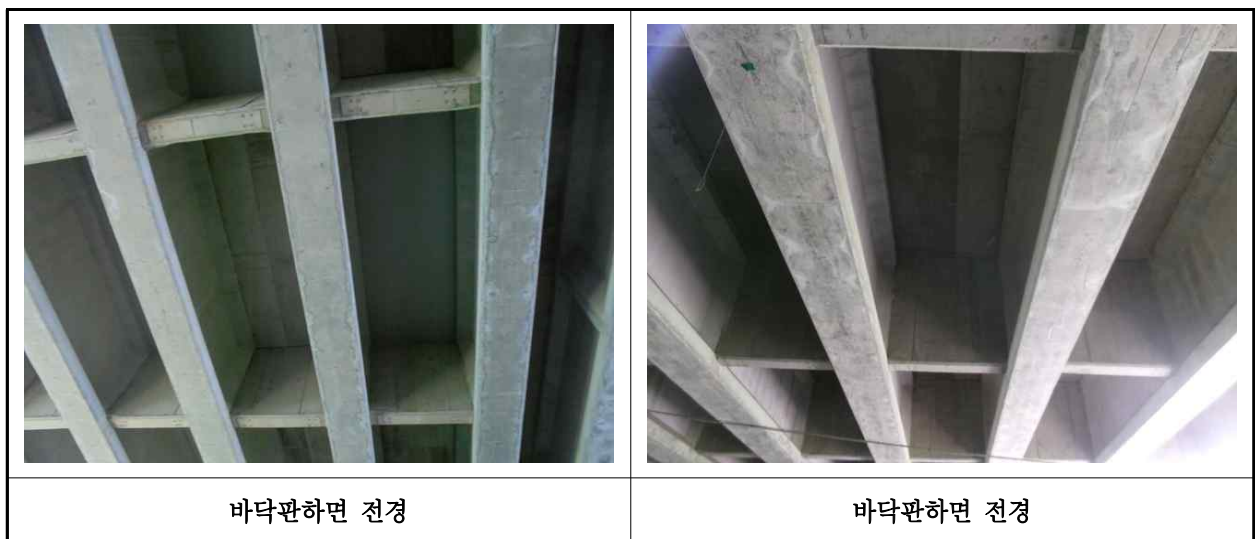
【사진 1.3.2】 바닥판하면 전경
