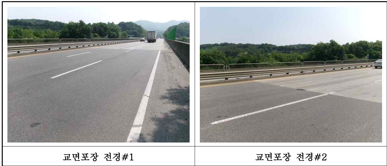
【사진 1.3.21】 교면포장 전경
