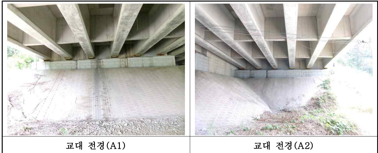
【사진 1.3.8】 교대 전경
