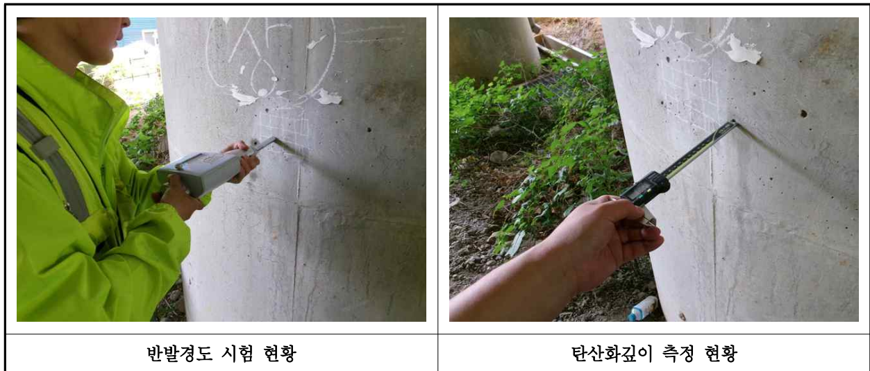
【사진 1.4.1】 콘크리트 내구성조사 현황
