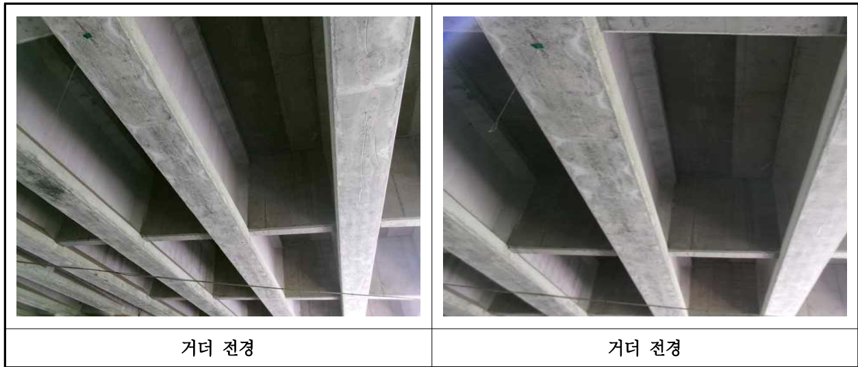
【사진 1.3.4】 거더 전경
